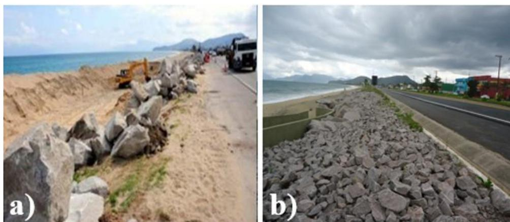
Figura 8: Construção do muro de contenção (Muro de pedra)
